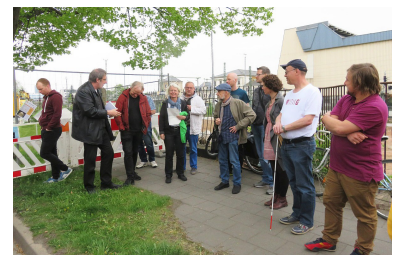
An der Baustelle Bahnsteigtunnel
