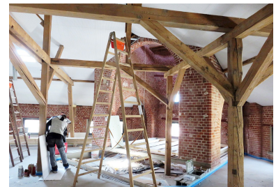
Ausbau der Turmstube
