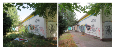
Ehemalige EDEKA-Kaufhalle an der Würzburger Straße 46.
