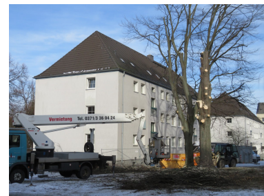
Würzburger Straße 56-62 - Beginn der Bauarbeiten und Baumfällung
